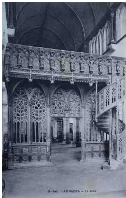
Escalera de acceso en Lambader (Bretaña) vista de este a oeste.
